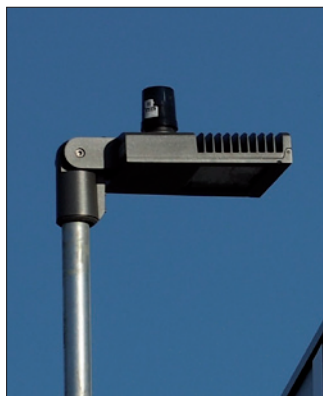
Obr. 9. Pro venkovní osvětlení byla vybrána svítidla Theos Glass, umožňující tzv. chytré řešení – řízení osvětlení s ohledem na provoz celého areálu
