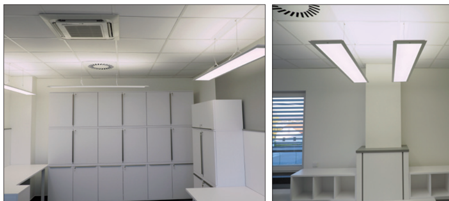
Obr. 7. Do kanceláří bylo vybráno designové svítidlo SL713 s přímým a nepřímým osvětlením a integrovaným senzorem pohybu a intenzity osvětlení
